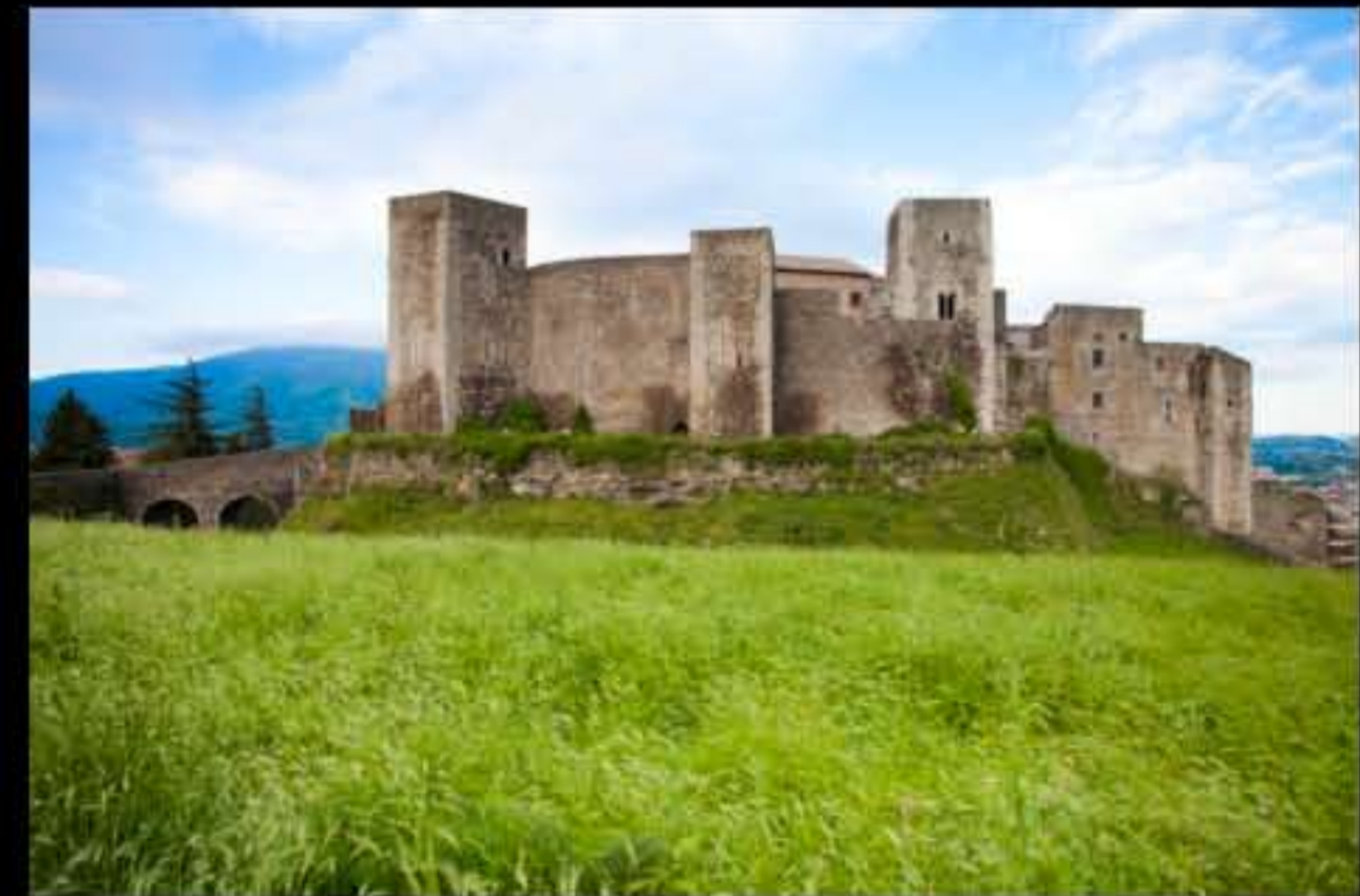
Melfi-207.jpg Italy, Basilicata, Melfi, castello
