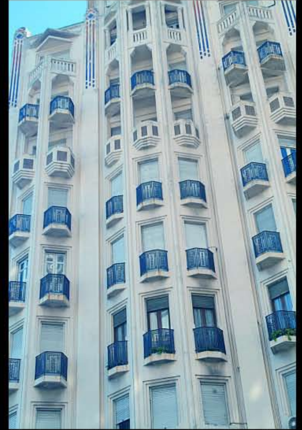
Montevideo Edificio in Plaza Independencia 001b
